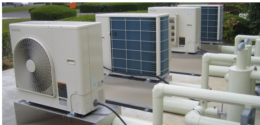
Suiren (睡蓮) システムの室外部 (チラー+熱交換器)
